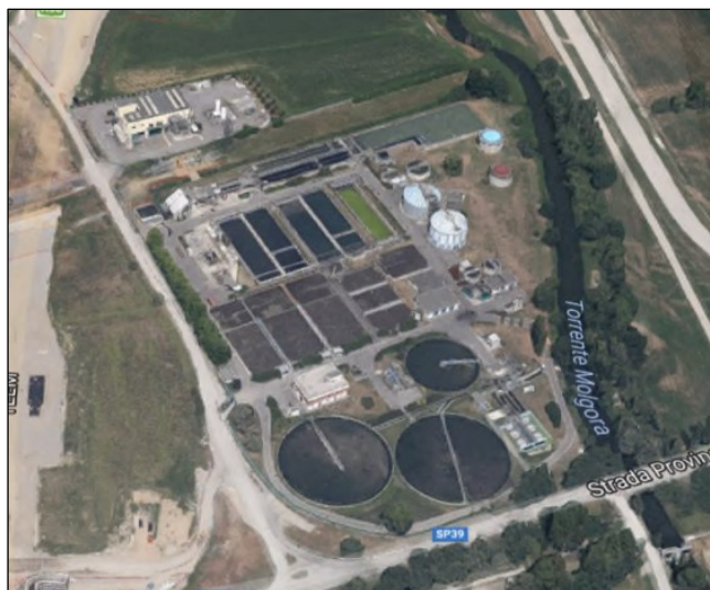
Fig.1.25 – Dettaglio depuratore consortile di Truccazzano
